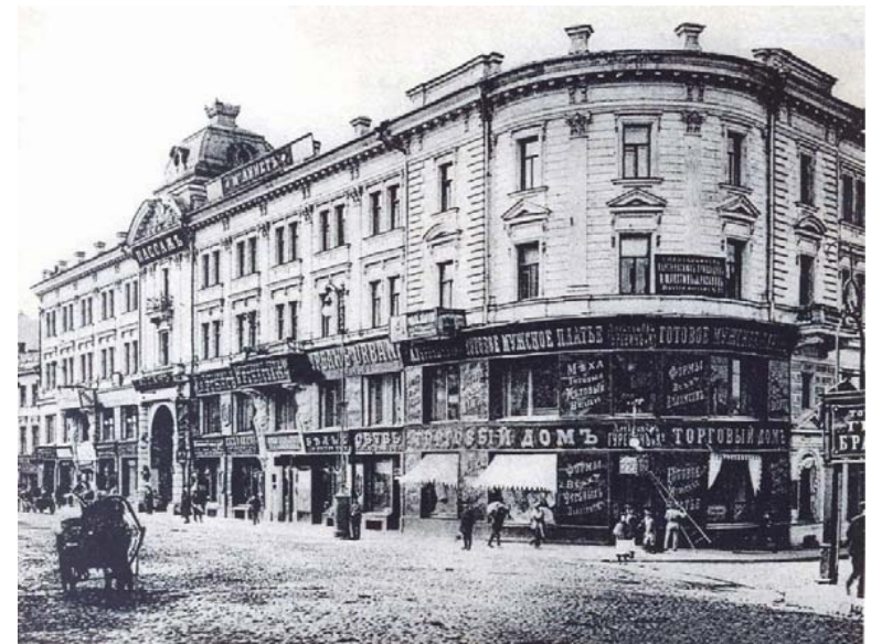
Тверская, 5. Постниковский пассаж. Инженер В.Г. Шухов, 1887 г.
