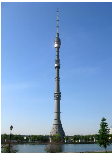
Останкинская башня (г. Москва)
