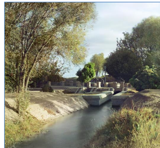
На 5-ом регуляторе. Царский (магистральный) канал Гиндукушской системы. 1911 г.
